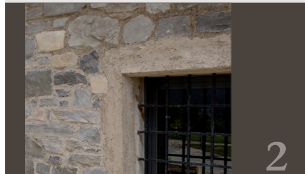
Fensterumrandung mit flächenbündig versenkten Steinen
