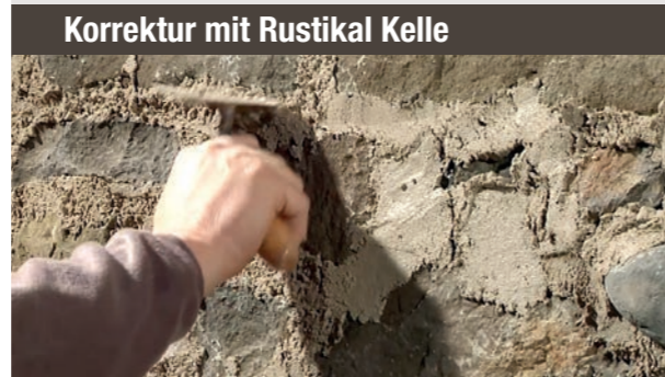
Korrektur mit gedrückter Rundspachtel
