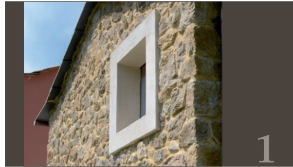
Fensterumrandung mit gespachteltem und eingefärbtem Rahmen
