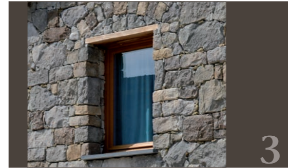
Fenstersturz mit Leistenstütze
