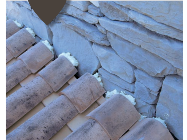
Im Bild ein Beispiel für falsche Installation.
