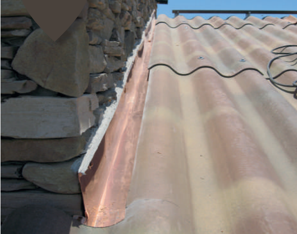
Im Bild ein Beispiel für falsche Installation.
